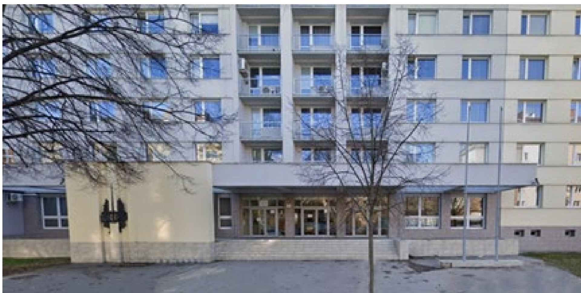
Hlavní vchod do budovy internátu Tučkova 23.
